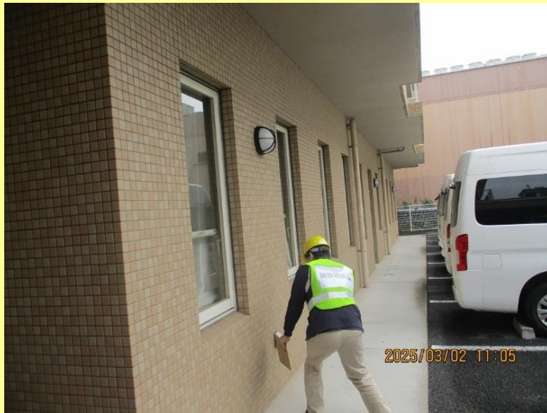
1Fフロア・建物 確認の様子
